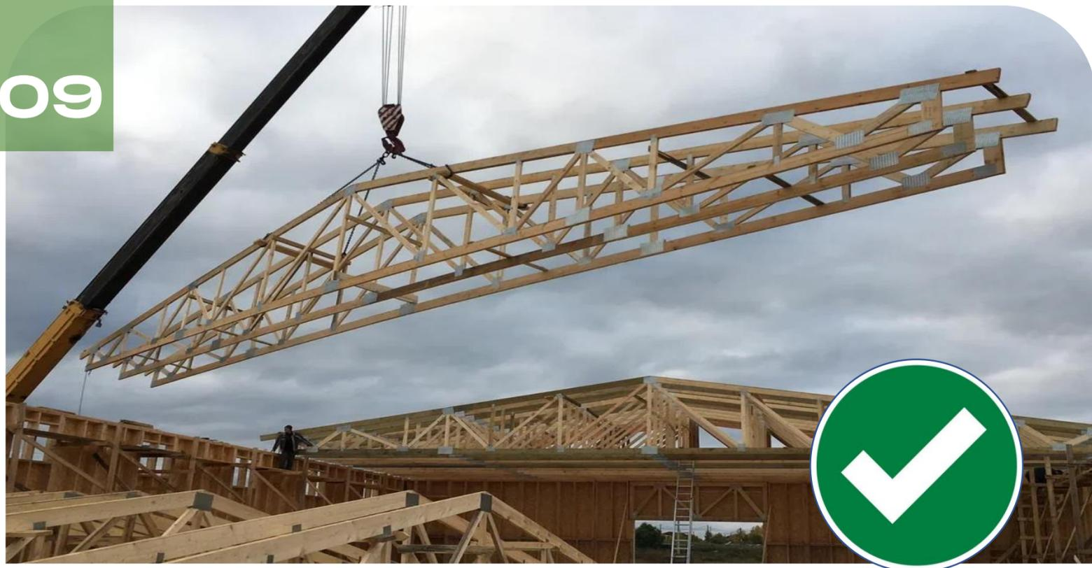
Фермы придают жесткость всему зданию, передавая на стены только вертикальные нагрузки, что особенно важно для каркасного домостроения. Дешевле ферм из металла в 2 раза, имеют малый вес.
